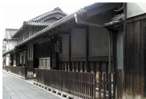
【春風館頼家住宅（手前）・復古館頼家住宅（ともに国指定重要文化財）】
