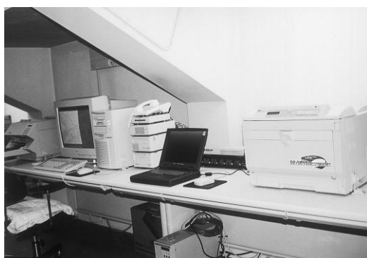
大気環境テレメータ装置（中央監視室）
