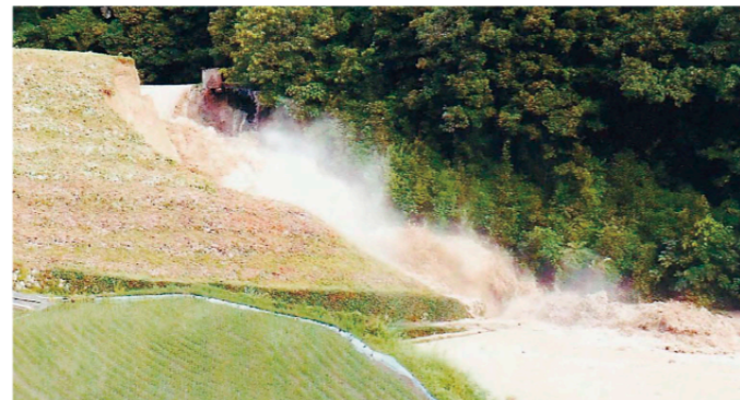
平成28年6月23日に発生したため池の決壊状況(福山市)
