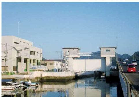
防潮水門(本川水系高潮対策)
