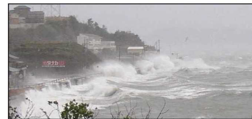
平成16年台風接近時の国道185号(竹原市忠海町)
