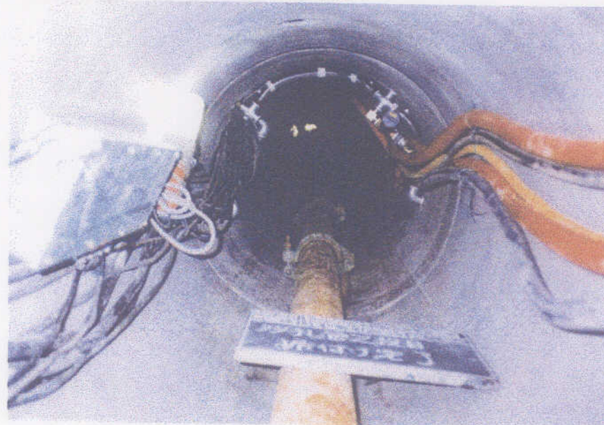
汚水幹線管渠（φ800mm）施工中管渠内
