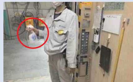
EVの操作盤等の消毒を徹底
