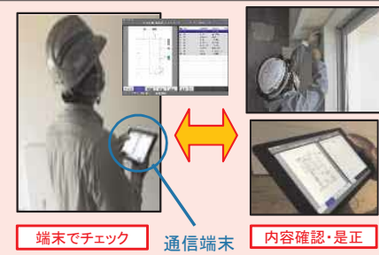
通信端末で内装仕上げの確認・是正
