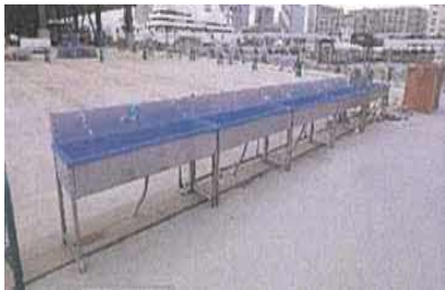
現場の手洗い場所の増設
