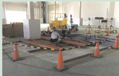
工事エリアの区画を設定して作業
