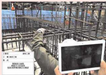
Webカメラを利用した遠隔検査
