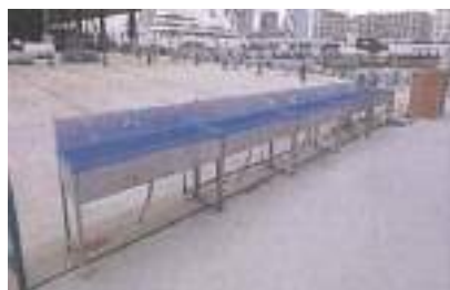
現場の手洗い場所の増設
