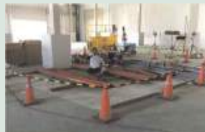
工事エリアの区画を設定して作業
