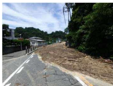
▲国道185号 的場公園付近（竹原市港町）
