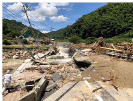
▲国道432号 葛子橋付近（竹原市新庄町）
