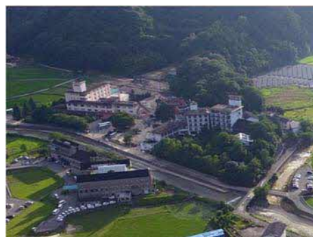
▲被災直後 湯坂温泉空撮 かんぼの宿裏土砂崩れ(竹原市西野町)
