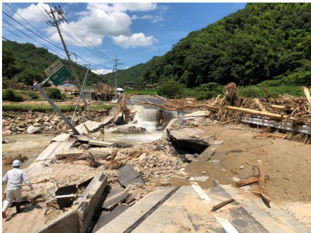
▲国道432号 葛子橋付近（竹原市新庄町）
