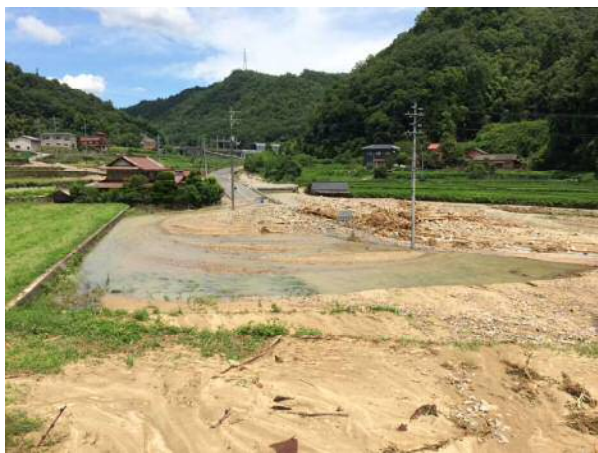
▲葛子川と国道432号 葛子橋北付近 (新庄町)
