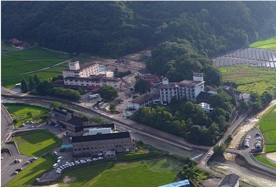
▲被災直後 湯坂温泉空撮 かんぼの宿裏土砂崩れ（竹原市西野町）
