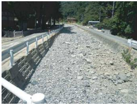
▲土砂が堆積した屋川（東野町）
