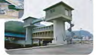
▼本川排水機場
