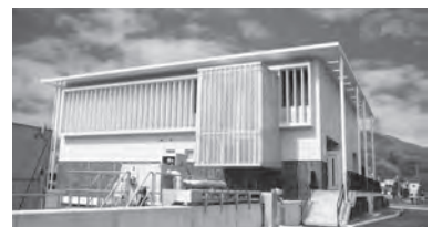
中央第2雨水排水ポンプ場
