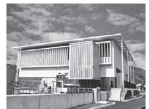
中央第2雨水排水ポンプ場
