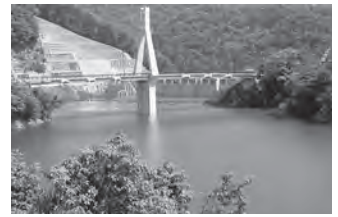
試験湛水中の仁賀ダム
