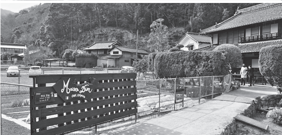
▲お二人が経営する「メゾンディオン」は、東野町の古民家を改修されています。
