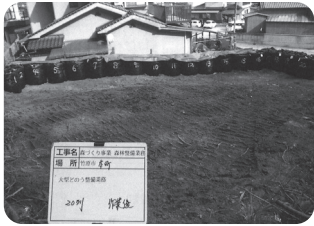
土砂流出防止の大型土のうの設置
