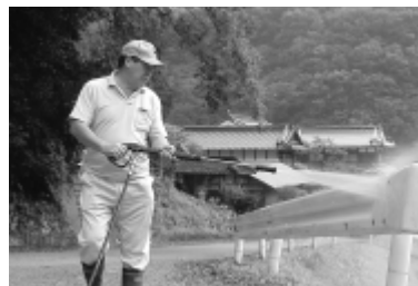
仕上げは高速洗浄で スポンジでこすった後は、高速 洗浄で一気に洗浄
