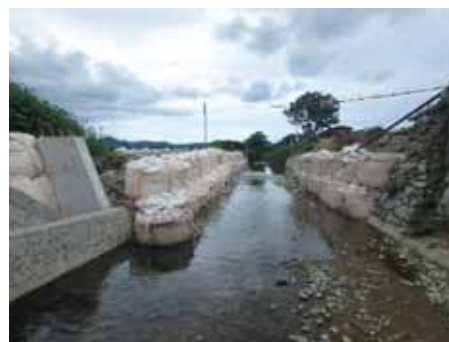
大型土のうの設置による仮復旧 (平成 30 年 (2018)9 月 26 日撮影)
