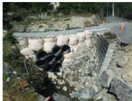
大型土のうの設置による仮復旧 (平成 30 年 (2018)10 月 19 日撮影)
