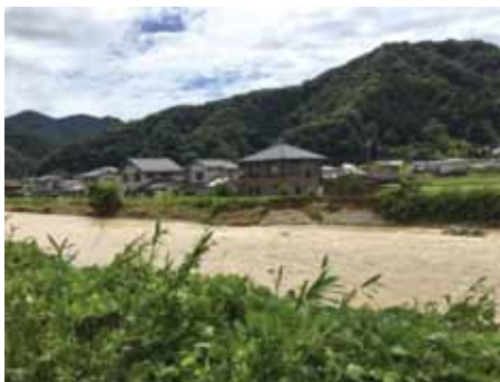
増水による堤防の斜面崩壊 (平成 30 年 (2018)7 月 8 日撮影)
