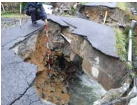
西の川増水による落橋 (平成 30 年 (2018)7 月 8 日撮影)
