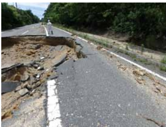
県道 75 号・小吹トンネル出入口付近（小梨町）
