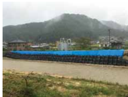
大型土のうの設置等による仮復旧 (平成 30 年 (2018)7 月 29 日撮影)
