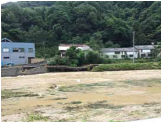
西上条 3 号線 1 号橋崩落（下野町）
