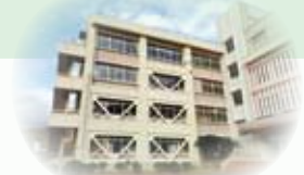
耐震改修（竹原小学校）
