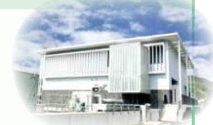
竹原市中央第2雨水排水ポンプ場
