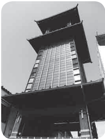
▲耐震化されたシンボルの時計台
