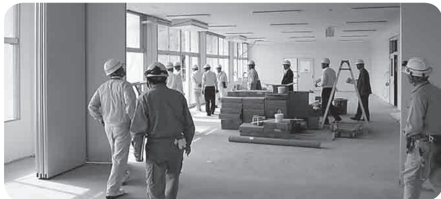
▲吉名学園の工事現場を視察する様子
