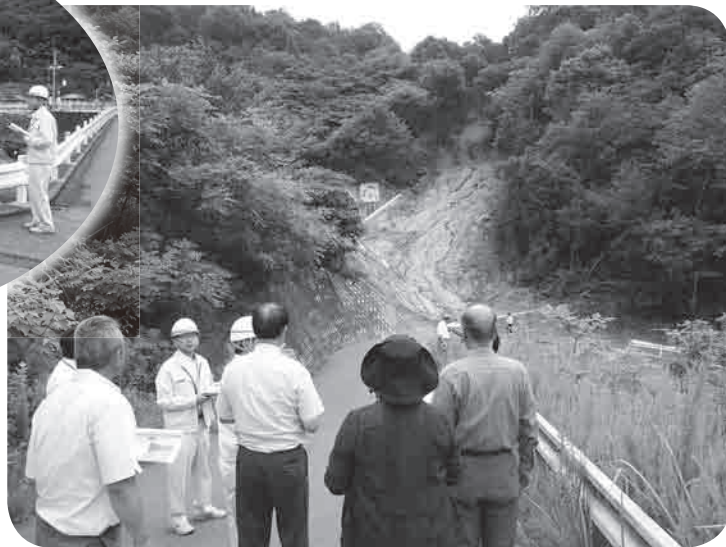
▲小吹トンネル前
