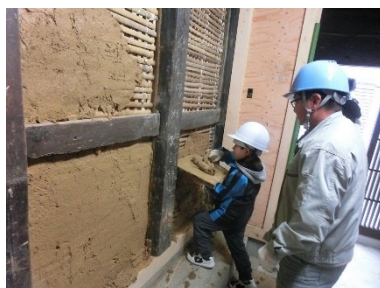
土壁塗り体験
