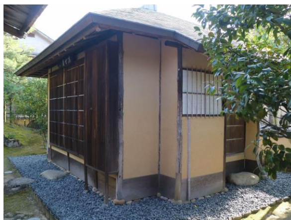
別棟となっている茶室
