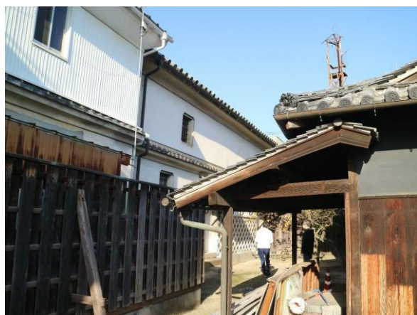
土蔵（土蔵は奥側、右手は主屋）
