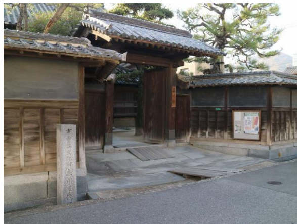
旧森川家住宅の玄関付近（木製板による段差解消）
