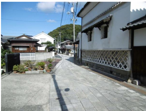
南西側（中ノ小路）から見た旧光本家住宅
