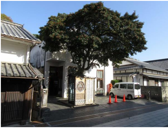
北西側（本町通り）から見た町並み保存センター
