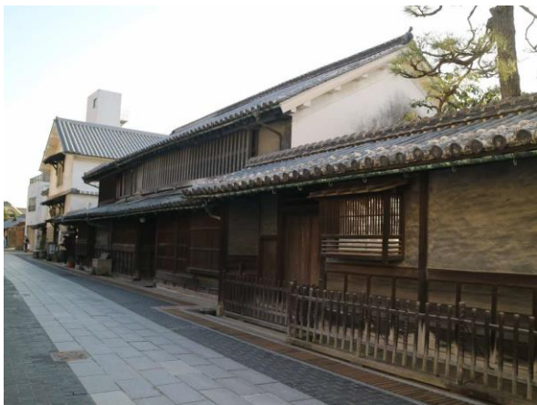
北側（本町通り）から見た旧吉井家住宅
