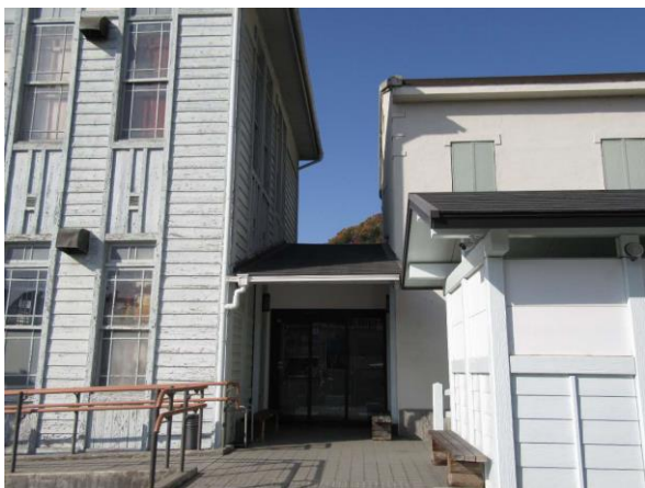
旧本館と旧書庫の1階をつなぐ部分
