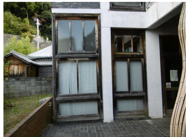
本町通りからの通路の先に位置する事務室など
