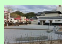
小公園(整備後)
