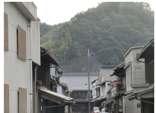
鎮海山のコンクリート擁壁が目立つ (伝建地区本町通り松阪家住宅前から南を望む)
