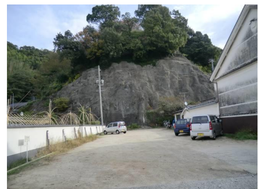
駐車場と寺山のコンクリート擁壁が目立つ(伝建地区内)
