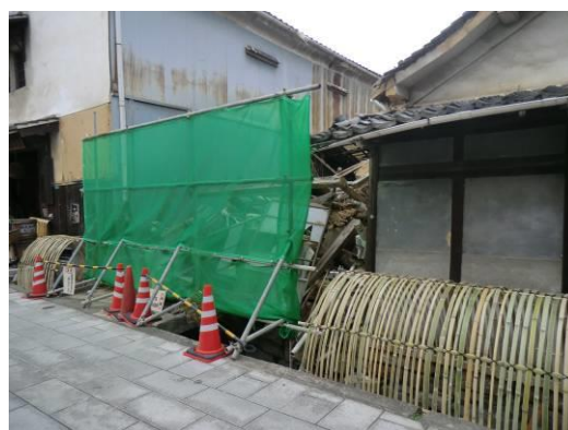
放置され倒壊した空き家
