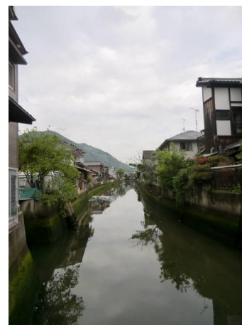
洪水対策区間の本川 (渡逢橋から北を望む)
