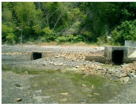
唐樋トンネル(寛延4年(1751)・写真左)
