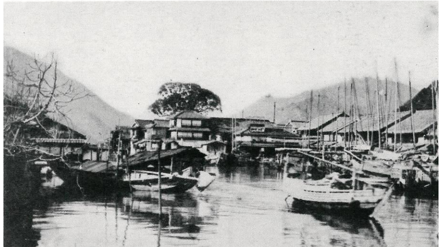
大正～昭和初期頃の港(正面の樹木は楠神社、神社左に渡逢橋、右側が掛町)
