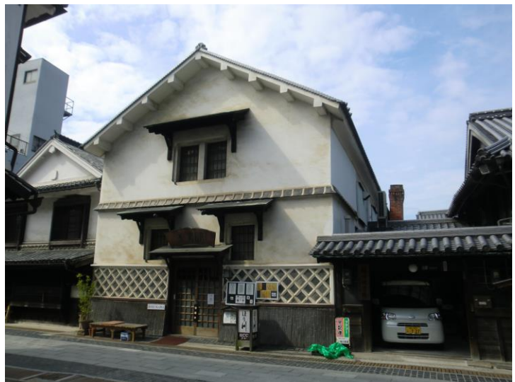
吉井家の酒造蔵(現堀川家土蔵・安政6年(1859)) 吉井家では昭和初期まで酒造業を営んだ。以後、醤油蔵として使用され、現在は食堂として使用されている。
