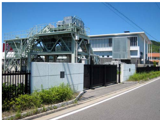
ポンプ場全景
