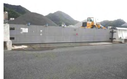
竹原内港高潮対策事業（防潮扉）
