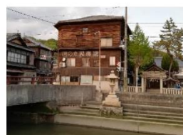
日の丸写真館（建造物）
