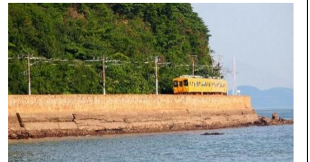
忠海町東町 (二窓港の駐車場から撮影)
