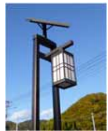
街路灯の設置
