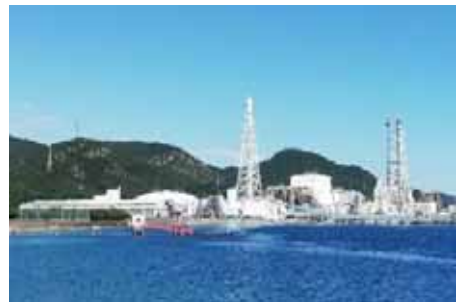
竹原火力発電所
