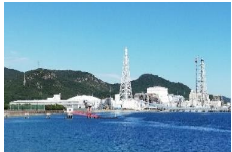
竹原火力発電所
