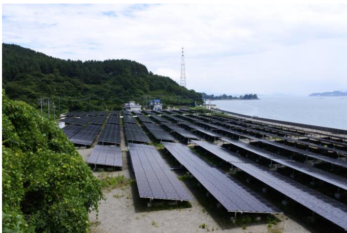
海岸沿いの太陽光パネル
