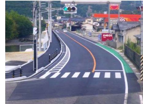
国道185号 歩道整備
