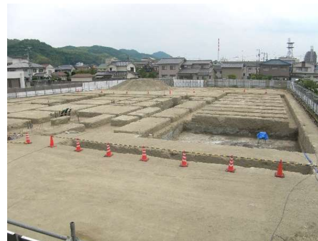
地盤改良工事完了
