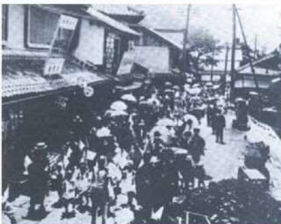
▲昔の掛町商店街の付近
