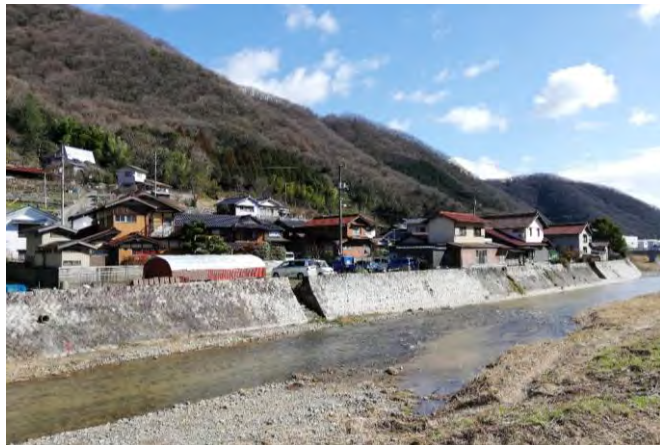
賀茂川（石積み護岸）
