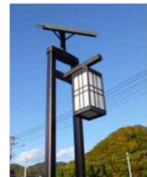
街路灯の設置
