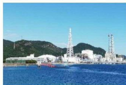
竹原火力発電所
