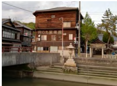
【建造物】 日の丸写真館
