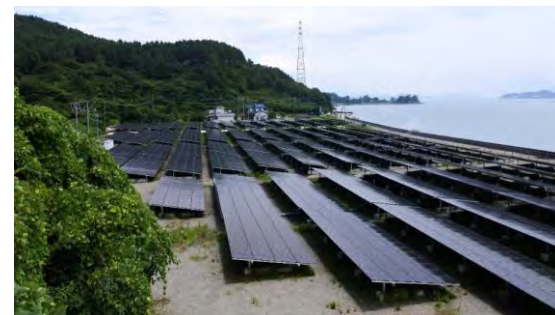
海岸沿いの太陽光パネル
