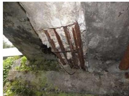
コンクリート主桁の鉄筋露出
