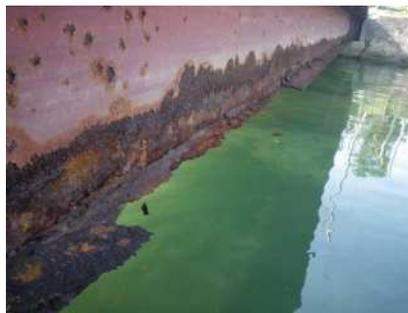
腐食による鋼桁の断面欠損
