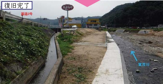
西野町の国道2号湯坂温泉入り口交差点下の賀茂川において、護岸が損傷していましたが、先月広島県による災害復旧工事が完成しました。
