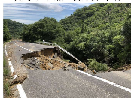
▲県道三原竹原線 トンネル西側 (小梨町)
