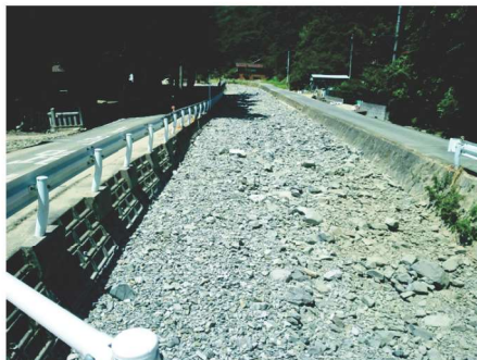
▲土砂が堆積した屋川（東野町）
