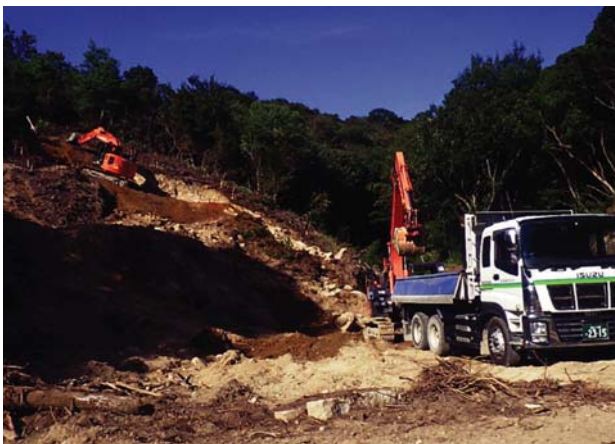
▲堰堤本体の床掘状況
