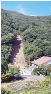
▲下仁賀地区 急傾斜地崩壊対策事業
