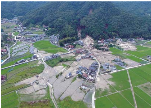
▲東野町 中条川被害直後の空撮
