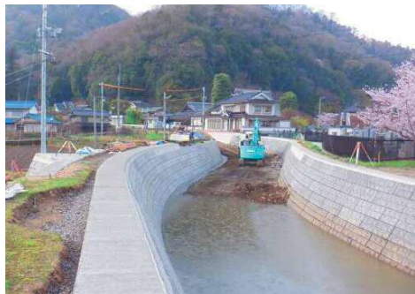
▲改修中の在屋川
