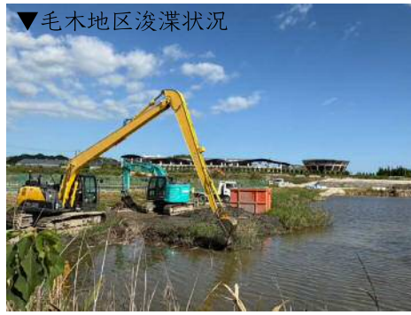
▼毛木地区浚渫状況
