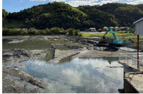
▼吉崎地区浚渫状況
