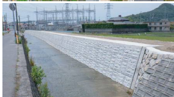
▶完成した築堤・護岸
