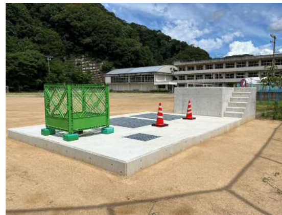
▲東野小学校グランド南東角へ、東野ポンプ場を整備しました。現在、ポンプ場へ流入する管渠や、ポンプ場に入った雨水を排水する管渠の敷設工事を進めています。河川で排水しきれない低地箇所の排水機能の向上を図ります。
