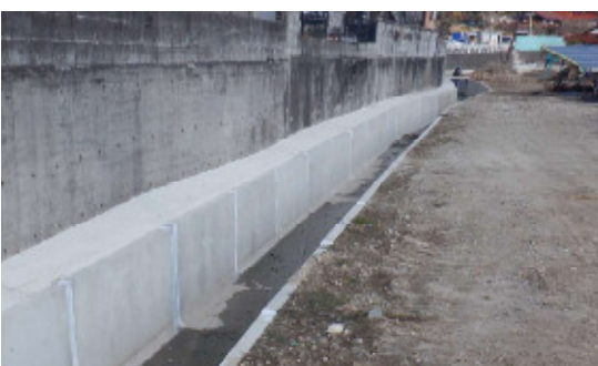
▲水路整備中(施工 ㈱中国工業開発)
