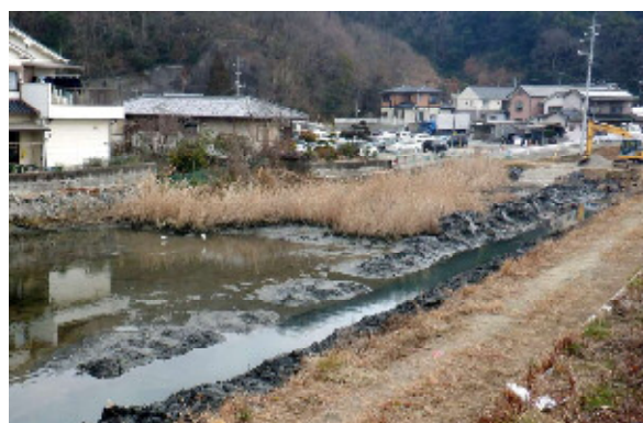
▲浚渫工事中（施工：㈱青木建設）
