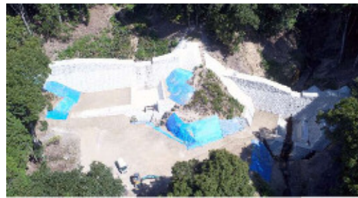
▲本堤の現在の状況
