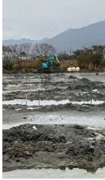
▲浚渫工事中（施工：㈱舛田組）
