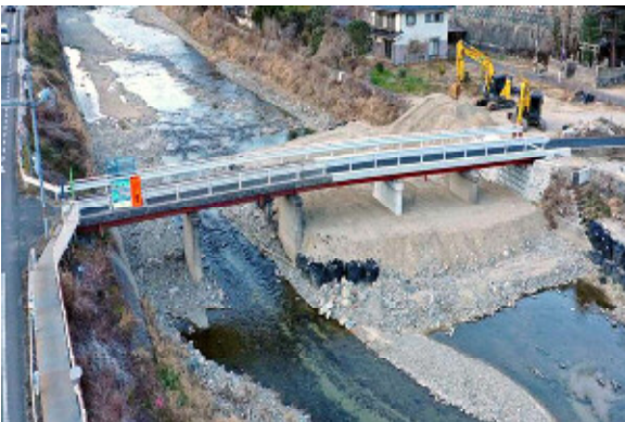
▲現在の状況（施工：沖元土建㈱）
