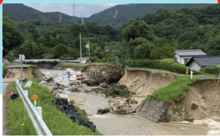
◀福田町 砂防河川東川 護岸崩壊 忠海町 ▼忠海学園法面崩壊
