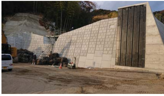
▲賀茂川支川7 12月18日本提完了
