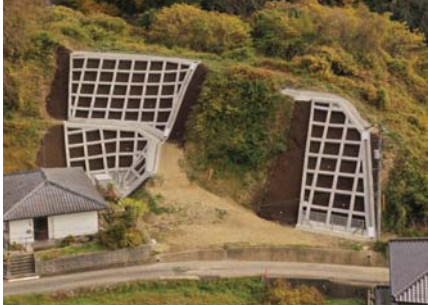
▲工事完成(施工:株中国工業開発)
