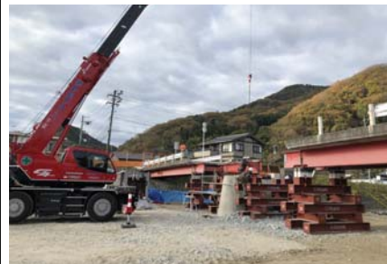
▲橋桁撤去(施工 株保手濱建設)
