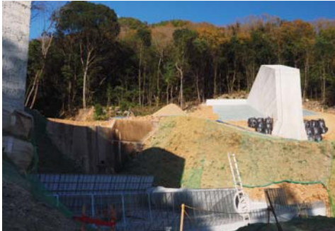
▲本提施工中(株)シンクストラクション
