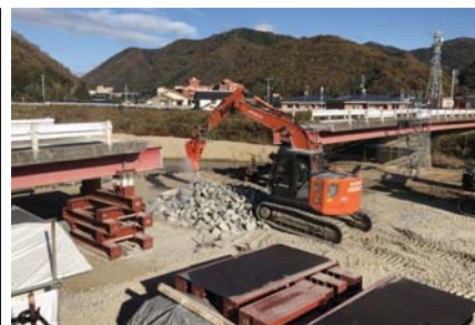
▲旧橋脚撤去(施工 株保手濱建設)
