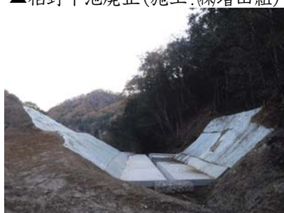
▲柏野新池廃止(施工:株増田組)
