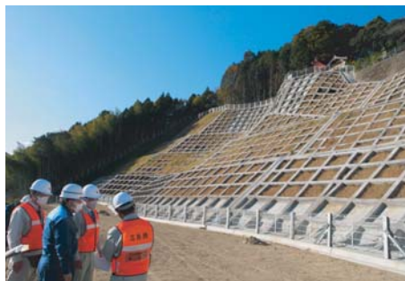
▲片山谷862地区(新庄町)災害関連緊急傾斜地崩壊対策事業
