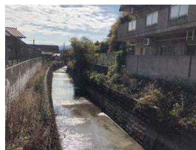
▲浚渫完了(施工:(有)竹親建設)
