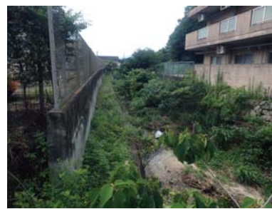
▲土砂堆積状況
