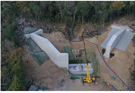
▲賀茂川支川8 本提施工中
