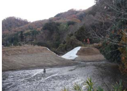
▲柏野下池廃止(施工:株増田組)
